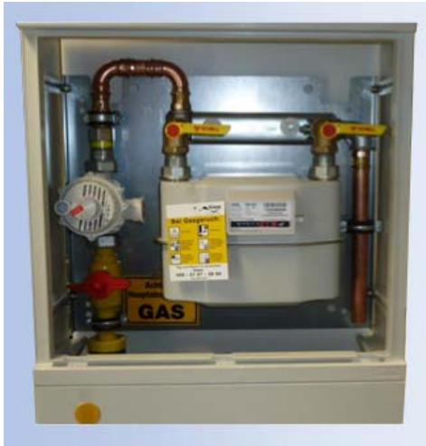
Bild 5,6: Zähleranschlusssäulen mit Abgang nach unten und hinten
