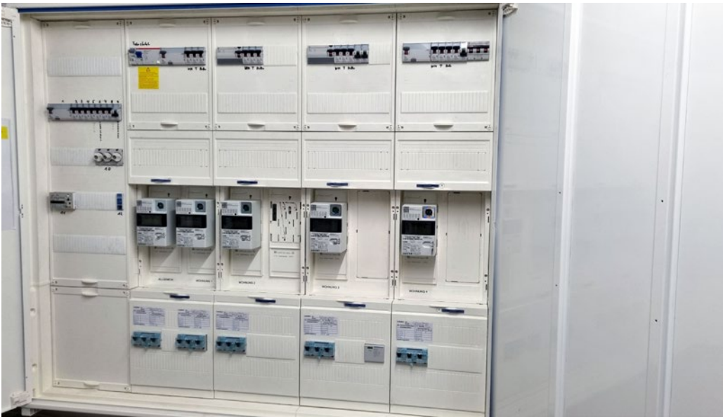
Strom Zählerschrank
