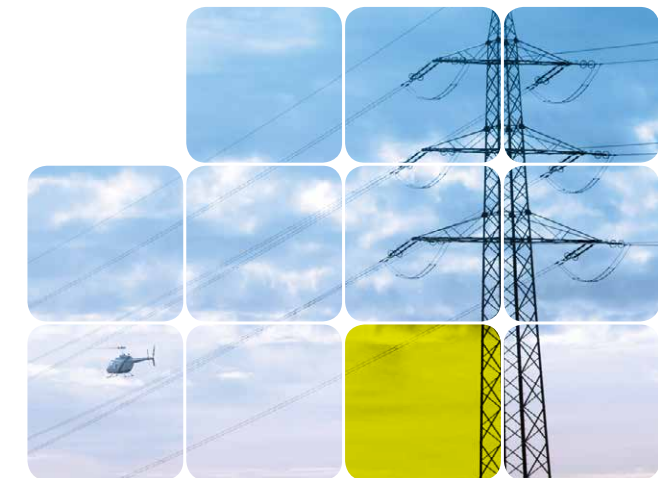
Die Syna sorgt zuverlässig für ein hohes Maß an Versorgungsqualität. Dazu trägt die jährliche Kontrolle per Hubschrauber aus der Luft bei.
